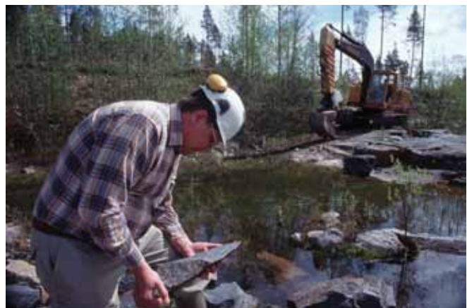
Jaakko työmaallaan. Sitä se on...
